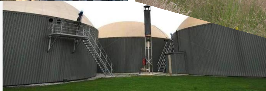
▲ Een biogasinstallatie. © Ed van Alem
